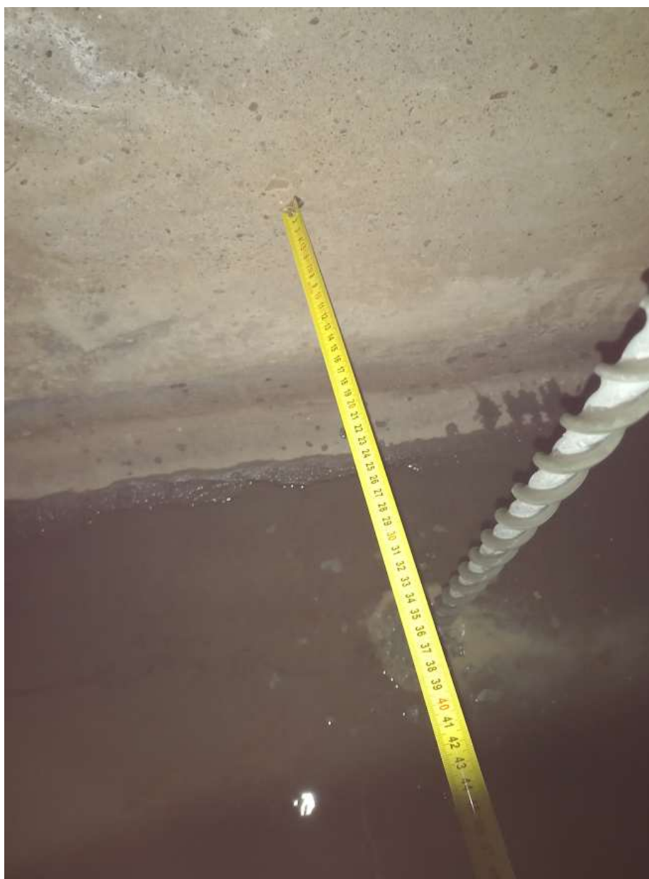
Zjištění konce základu 350 mm od líce před opěrou
