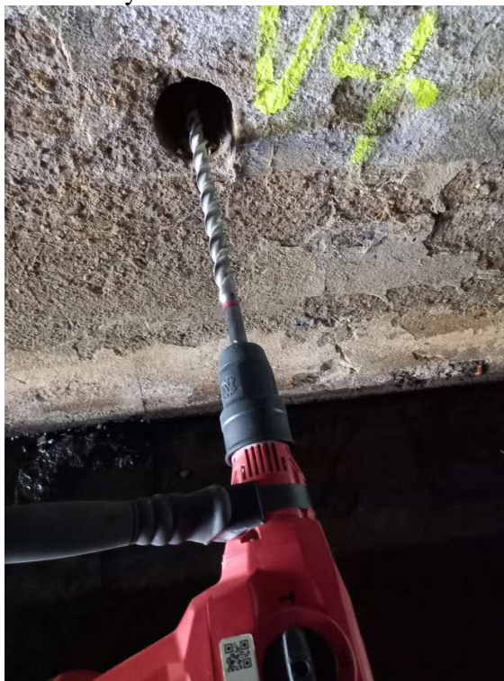
Provádění vývrtu do opěr v místě pod komunikací na ulici Dolní Brána.
