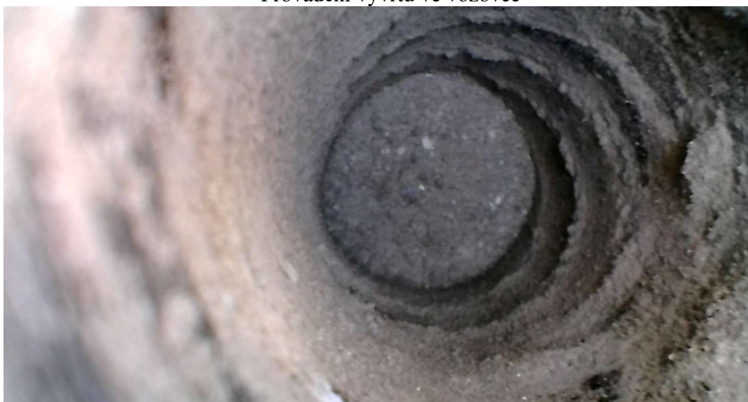
Provádění vývrtu ve vozovce
