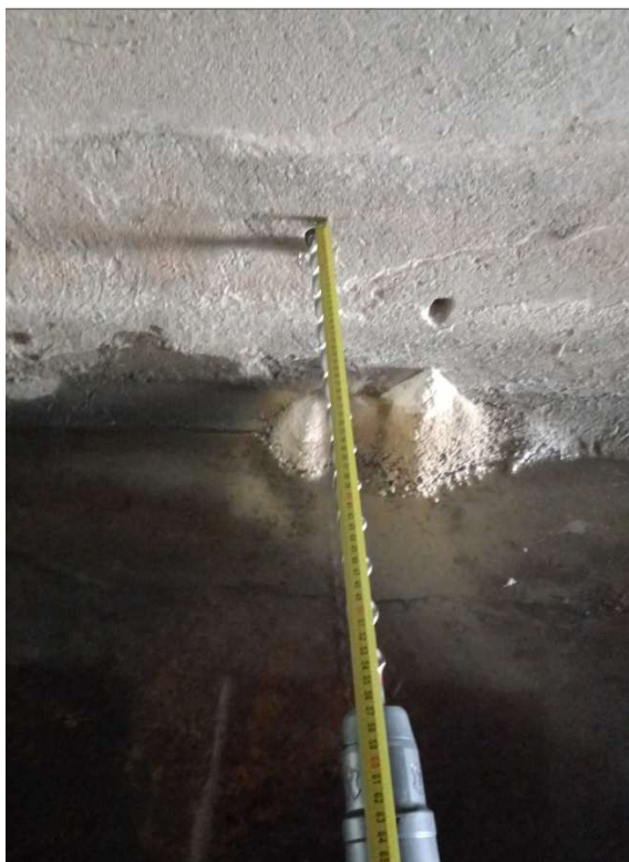
Provádění vývrtu do opěr podél sousedního domu, na více místech i více výškových úrovních
